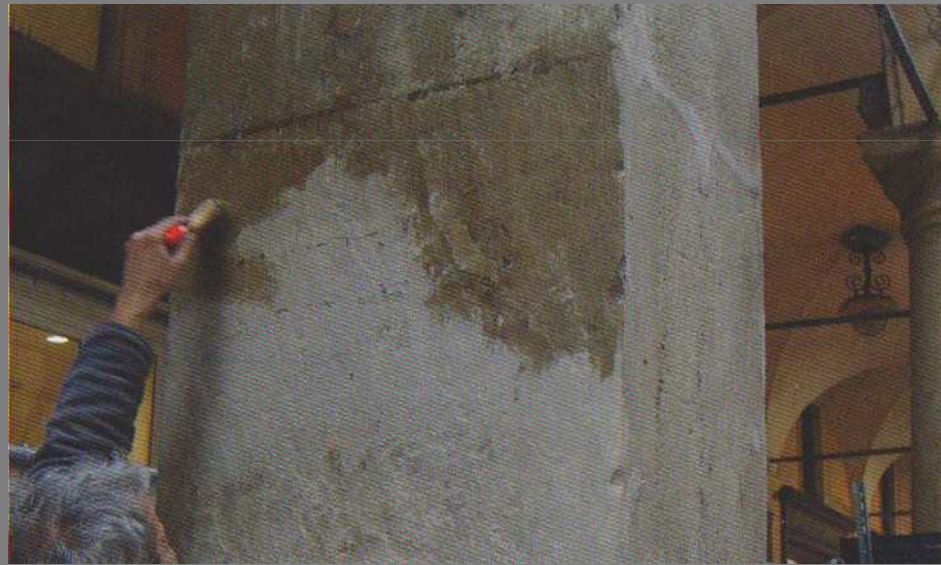
Stesura di trattamento protettivo
