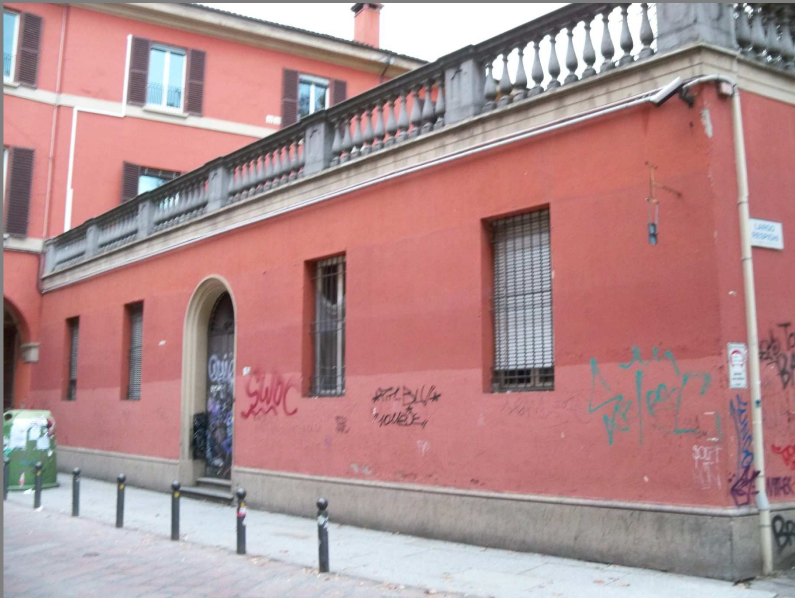
Ufficio Scolastico Regionale , Bologna - Prospetto su Via de' Castagnoli
